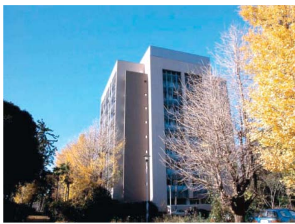
医学薬学総合研究棟第1期工事新営 (平成15年12月撮影)
