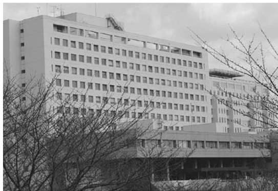
◀ 現病棟 (右側新病棟)
